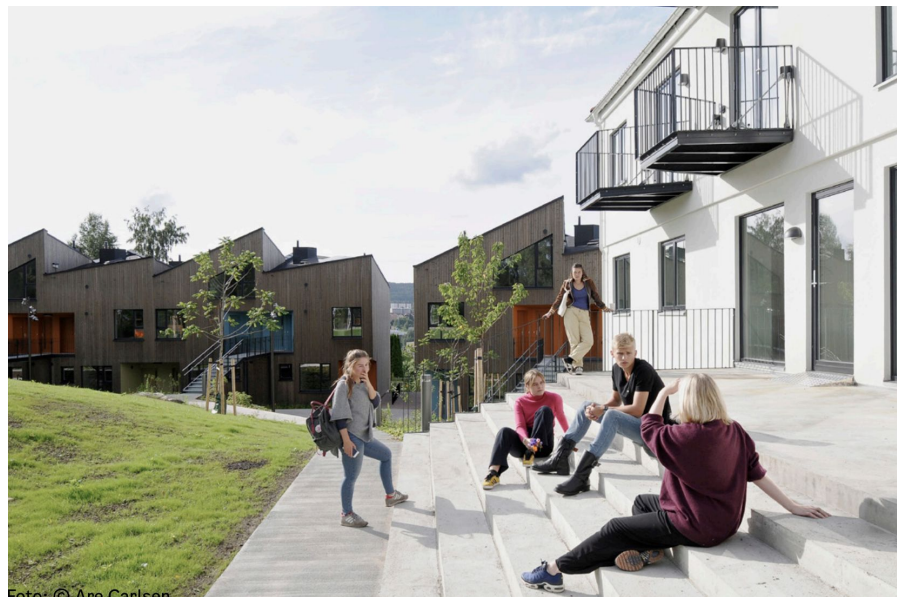
Ulsholtveien 31, førstehjemsboliger på Furuset
