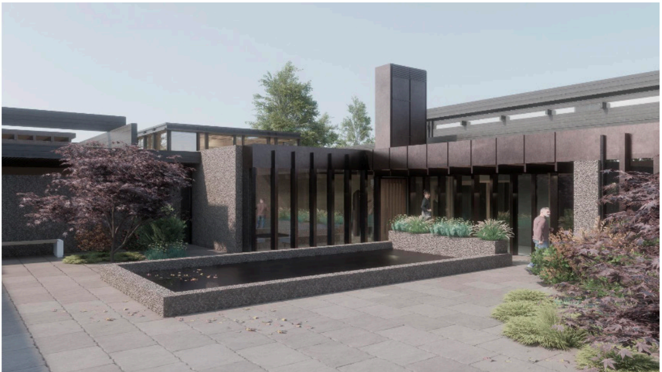
Inngang administrasjon og venteområde. Takoppløft over ovnsrom og ny pipe. Nytt belegg og frodig beplantning for skjerming mot administrasjonsdel.
